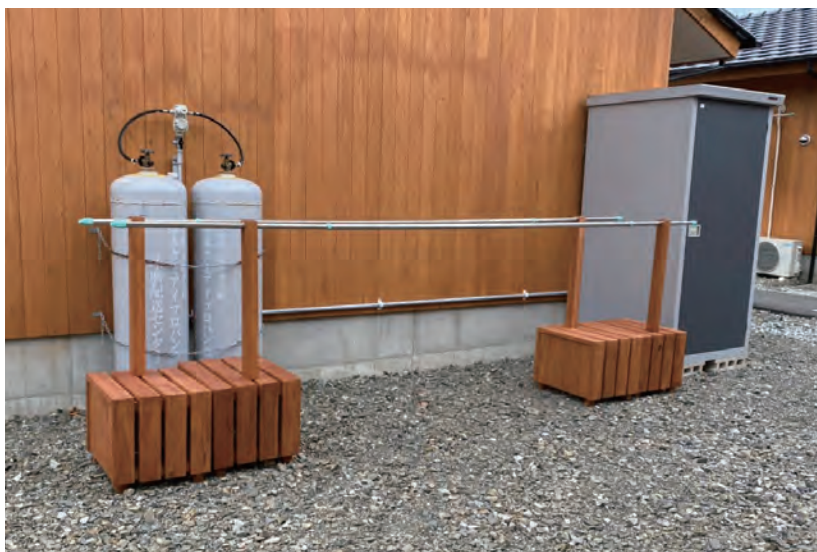
▲ 住棟の間に設置している例 日のあたる場所に移動させることもできる
